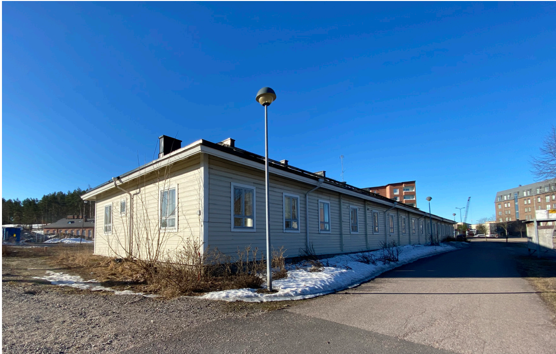
Kuva 39. Rakennus Kymppi kadun puolelta 1.4.2021.
