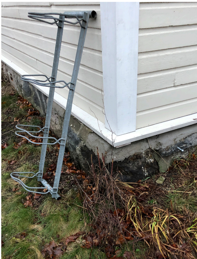
Kuva 40. Kuva perustuksista ja ulkoverhouksen alaosasta. 15.12.2021.
